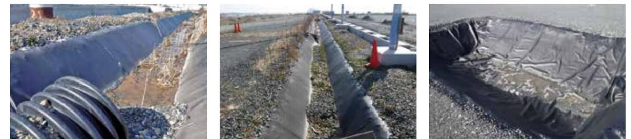
**用途** 調整池、雨水貯留施設など **材質** 塩化ビニル
