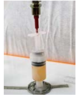
追い打ち注入の様子
