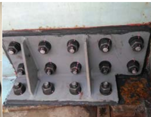
当て板工法処理の様子
