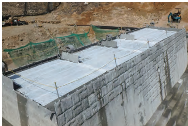
砂防堰堤天端
