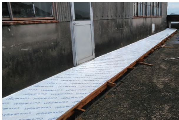
建物の犬走り
