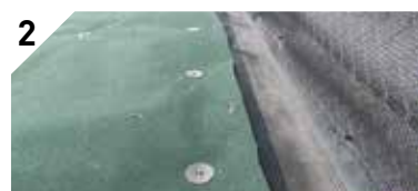
フェンス足元の処理
