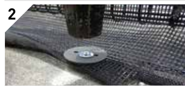
フェンス足元の処理
