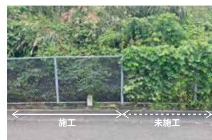
施工・未施工の比較
