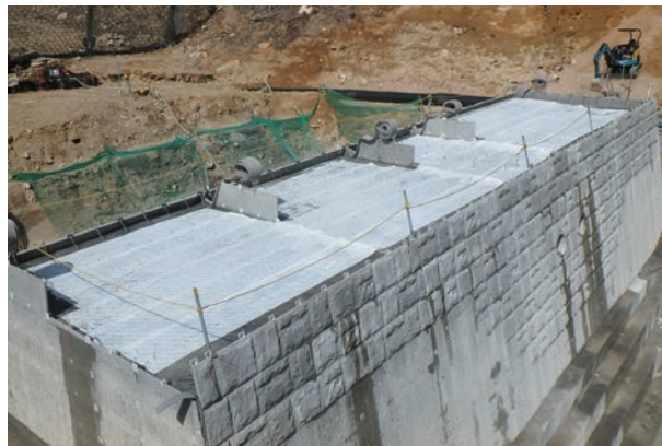
砂防堰堤天端
