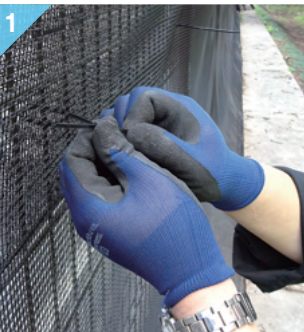
フェンス等にバリオスネットを設置します。
