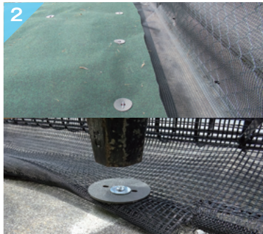
フェンス足元の処理
