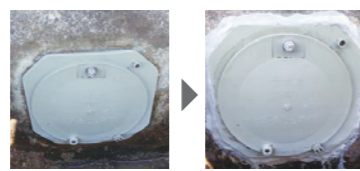
分水栓の補修
