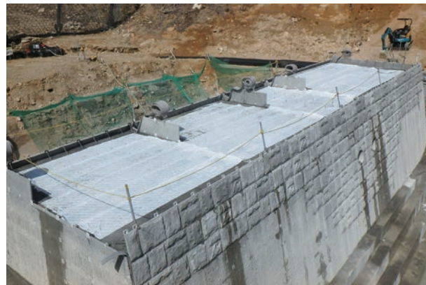
砂防堰堤天端
