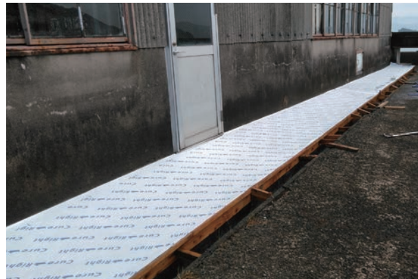
建物の犬走り
