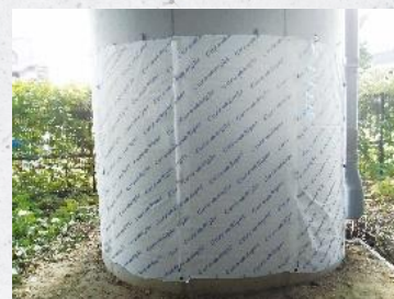
垂直面への施工現場写真
