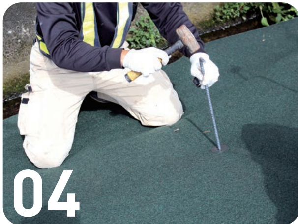
目串を打設します
