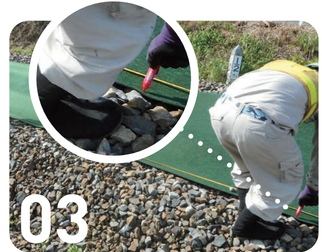
仮止めし、目串打設箇所にマーキングを行います
