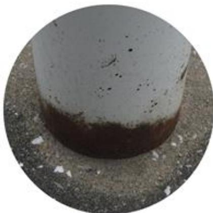
柱脚部の腐食
